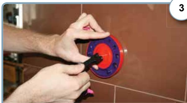
Зафиксируйте кондуктор на плитке поворотом рычага.
