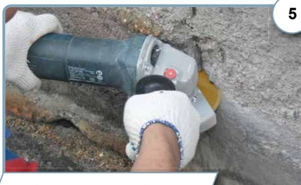
Резка армированного бетона
