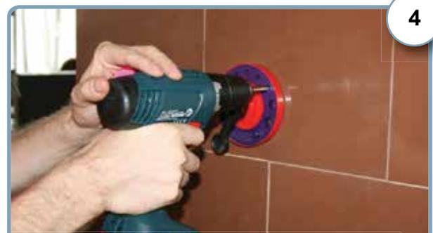
Просверлите отверстие с помощью алмазной коронки.
