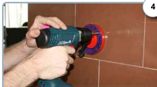
Просверлите отверстие с помощью алмазной коронки.
