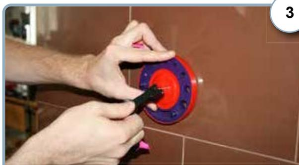
Зафиксируйте кондуктор на плитке поворотом рычага.
