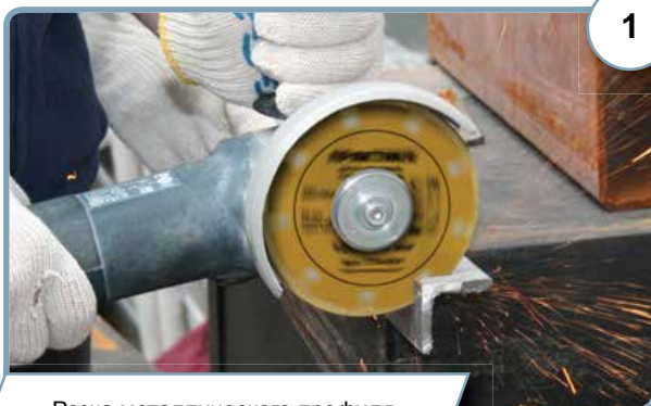
Резка металлического профиля
