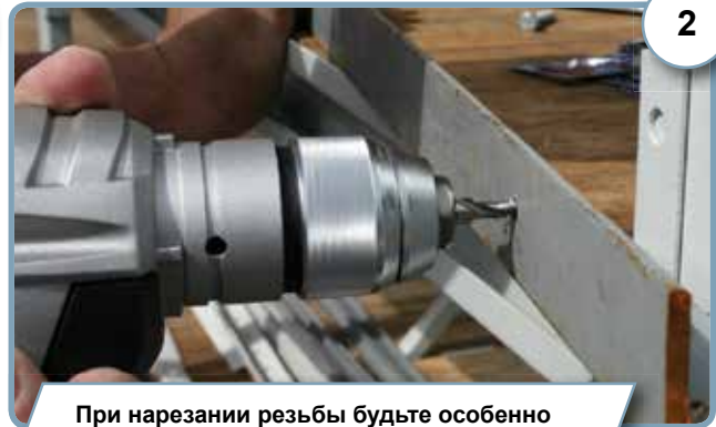
При нарезании резьбы будьте особенно внимательны, не допускайте перекоса.
