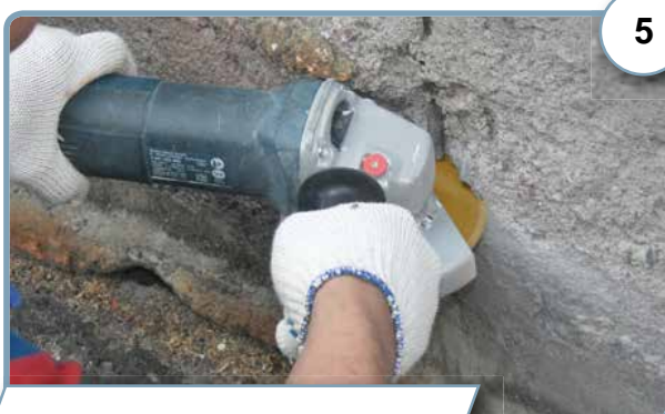
Резка армированного бетона
